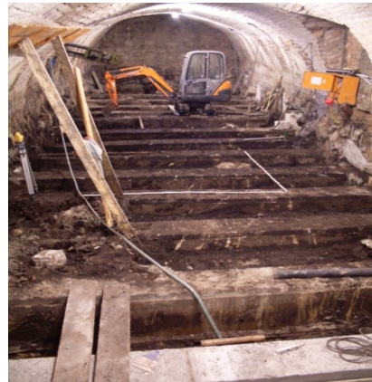
TF, Baruth, Frauenhaus, Keller, Kernbau 1596/1600 mit horizontalen Stahlbetonbalken, Quelle: O. Brauer, 2010
